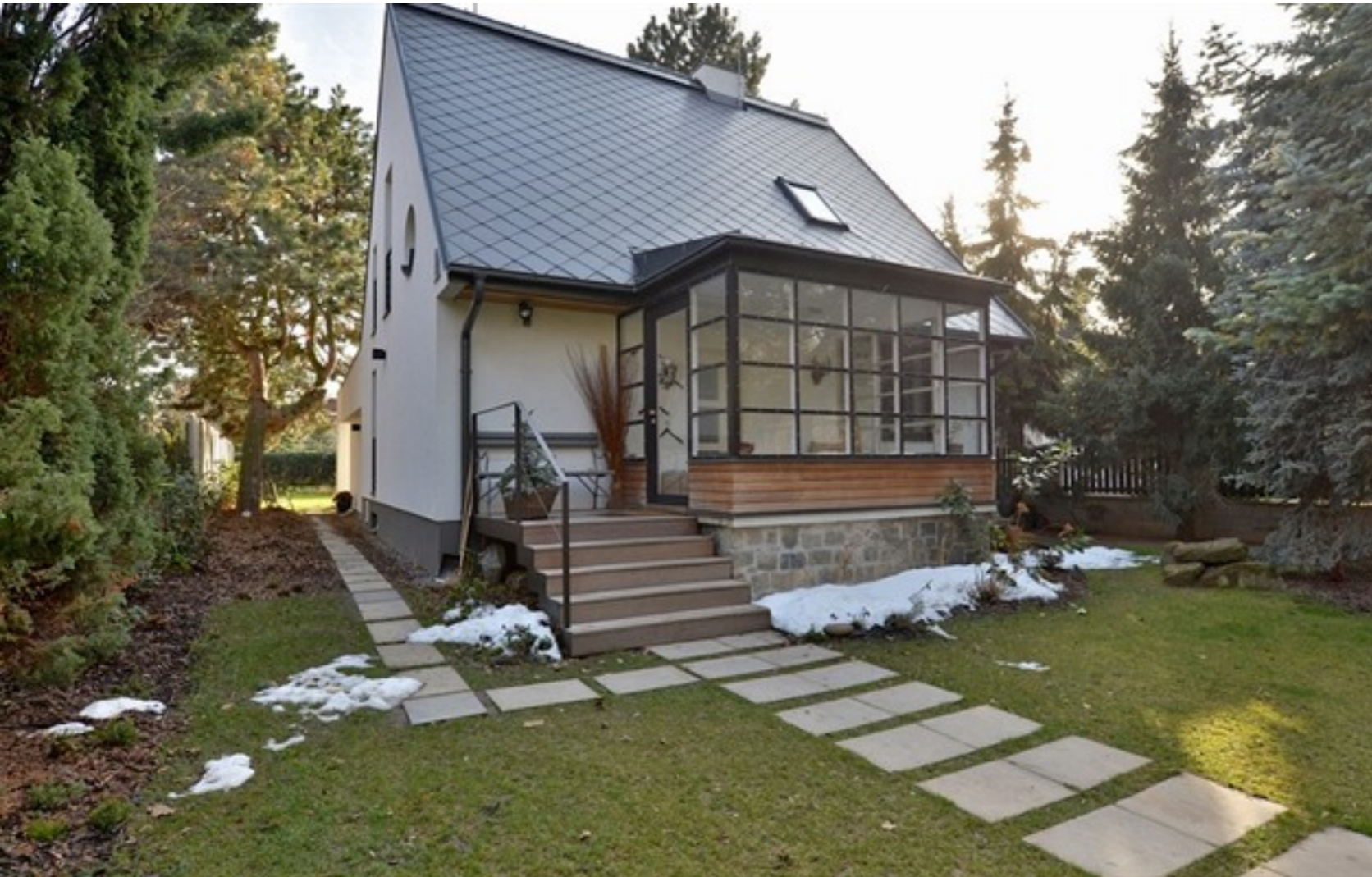
Pohled z ulice na dům po rekonstrukci | foto: Archiv majitelů
