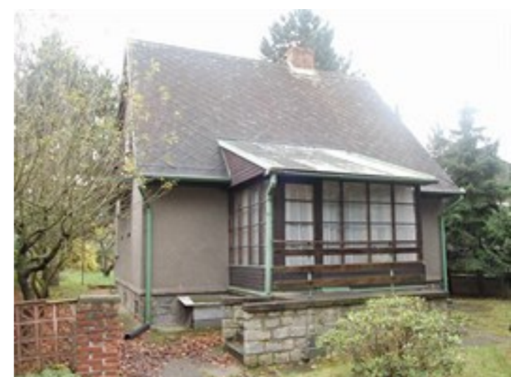
Pohled z ulice na dům před rekonstrukcí
